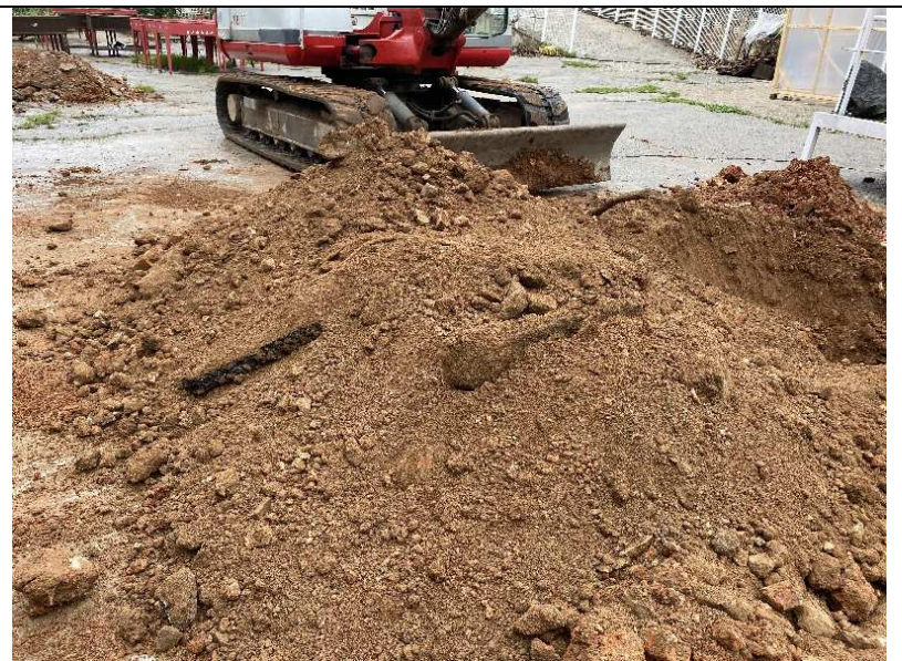
Detall dels materials de la cala C-3
