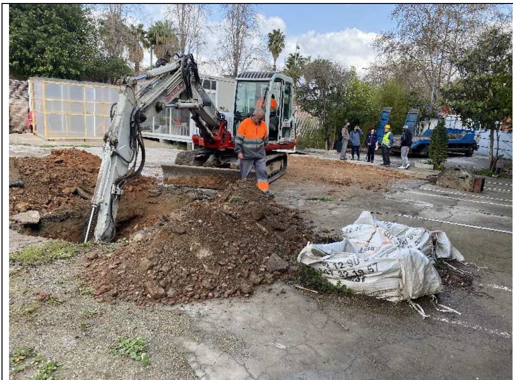
Parcel·la coberta de formigó en gran part -cotes 11,91 i 12,18-
